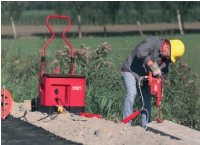
Abb. 7: Optimierung der Arbeitsprozesse beim Kunden. Aufwändige Beschaffung von Kühlwasser entfällt durch die mobile und autarke Einheit zur Kühlwasserversorgung
